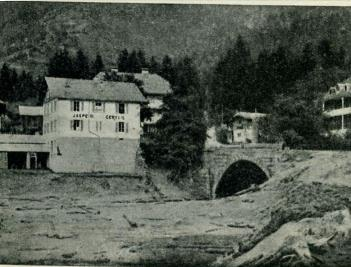
Fig. 22. — Le pont de la route départementale n° 4 tourné et submergé par la lave.
