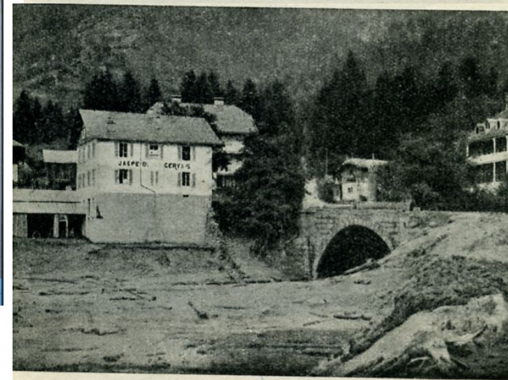
Fig. 22. — Le pont de la route départementale n° 4 tourné et submergé par la lave. 13 juillet 1892. — Cliché Kuss.
