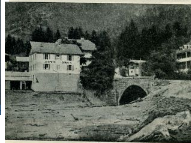
Fig. 22. — Le pont de la route départementale n° 4 tourné et submergé par la lave. 13 juillet 1892. — Cliché Koss.
